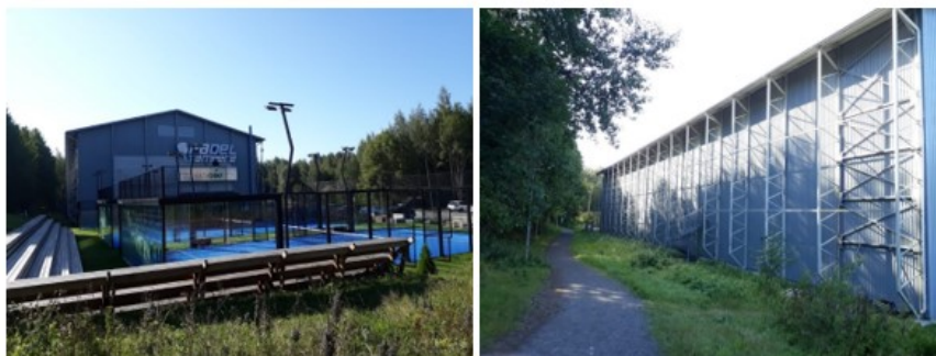
Kuva 2. Vasemmalla halli ulkoalueineen, oikealla kevyen liikenteen väylä hallin takasivulla. ©Tampereen kaupunki 2021
